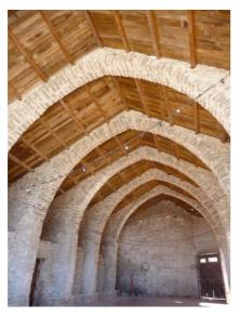
La couverture: Les arcs supportent une panne faîtière et des pannes de versant, ainsi que la volige constituant la charpente d'une couverture en lauze calcaire du pays ou de tuiles canal, généralement à deux versants. Les structures en bois sont en chêne ou en pin.
