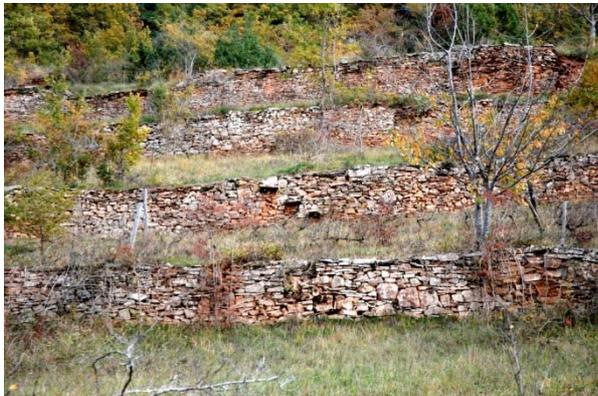
**Epaisseurs et dimensions** : Pour les murs de terrasses cultivées, la hauteur des ouvrages ne dépassera pas 1,50m. Règle de base : la largeur de la base du mur est égale à 1/3 de la hauteur.
