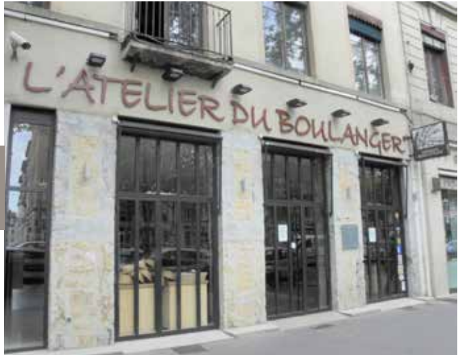
Seuils des portes au niveau du trottoir.
