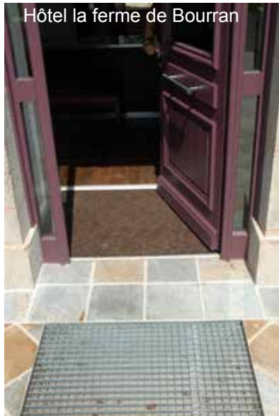
Les grilles de seuil sont tolérées si la maille est inférieure à 2cm.
