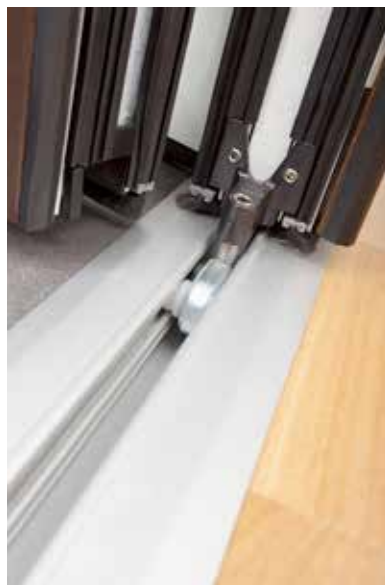
Gestion de seuils conçus de manière à éviter les ressauts.
