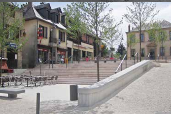
rampe vers la rue de l'Hospitalet avant travaux
