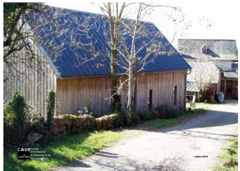
bardage vertical Douglas à clins naturels - ossature pin et panneau OSB - couverture bac acier
