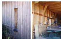
bardage vertical Douglas à clins naturels - ossature pin et panneau OSB - couverture bac acier
