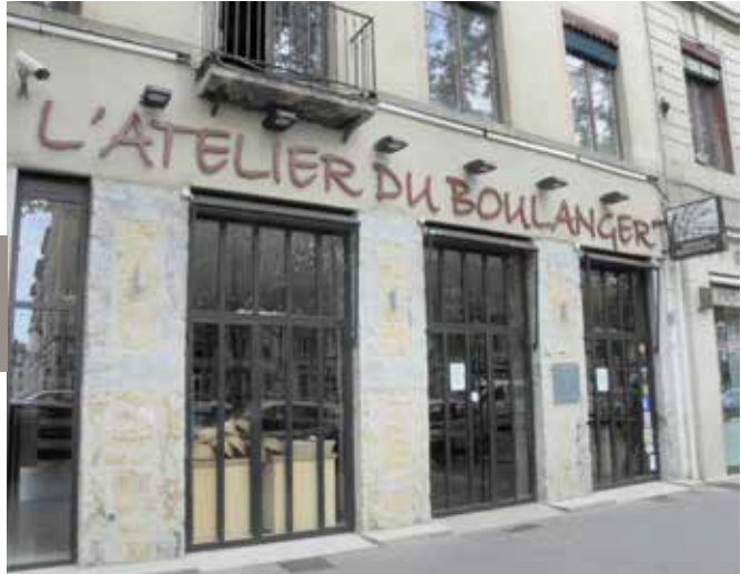
Seuils des portes au niveau du trottoir.
