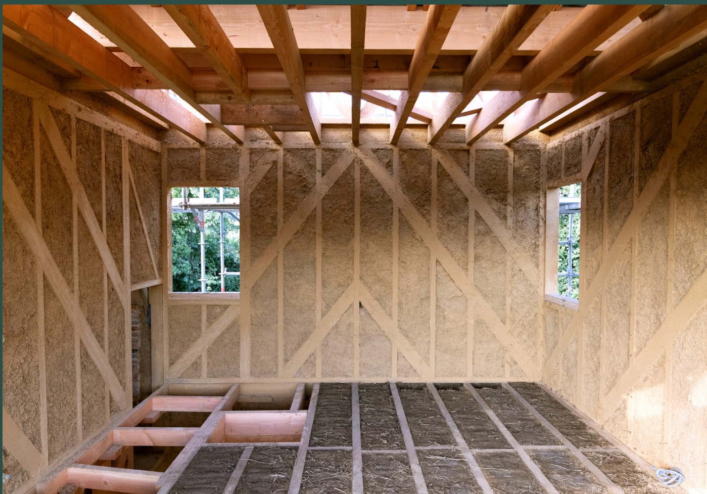
Isolation terre+chanvre dans l'extension
