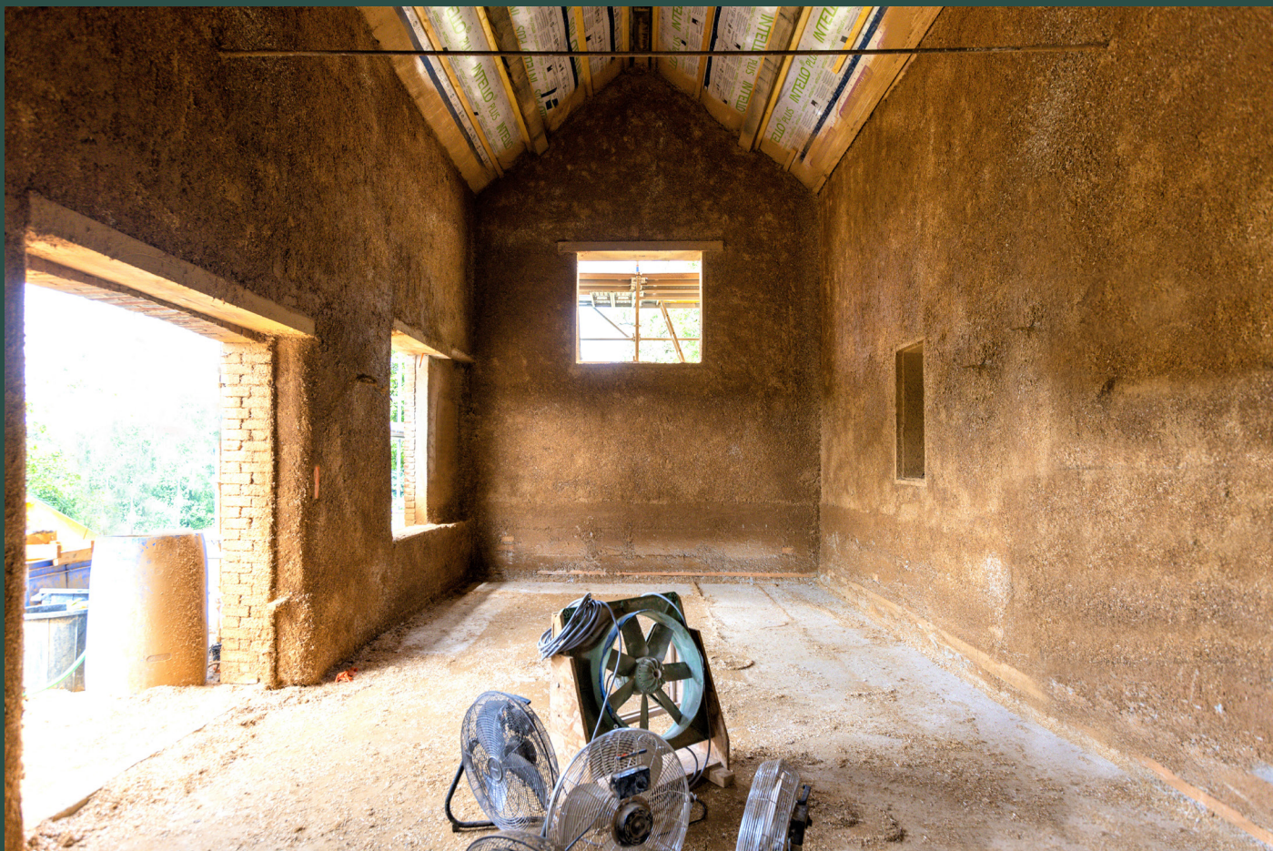
Isolation terre chanvre dans la partie rénovée
