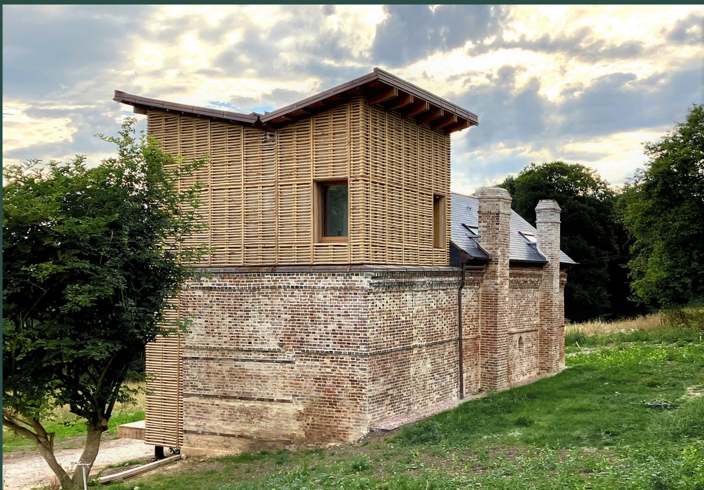
La rénovation vue côté est
