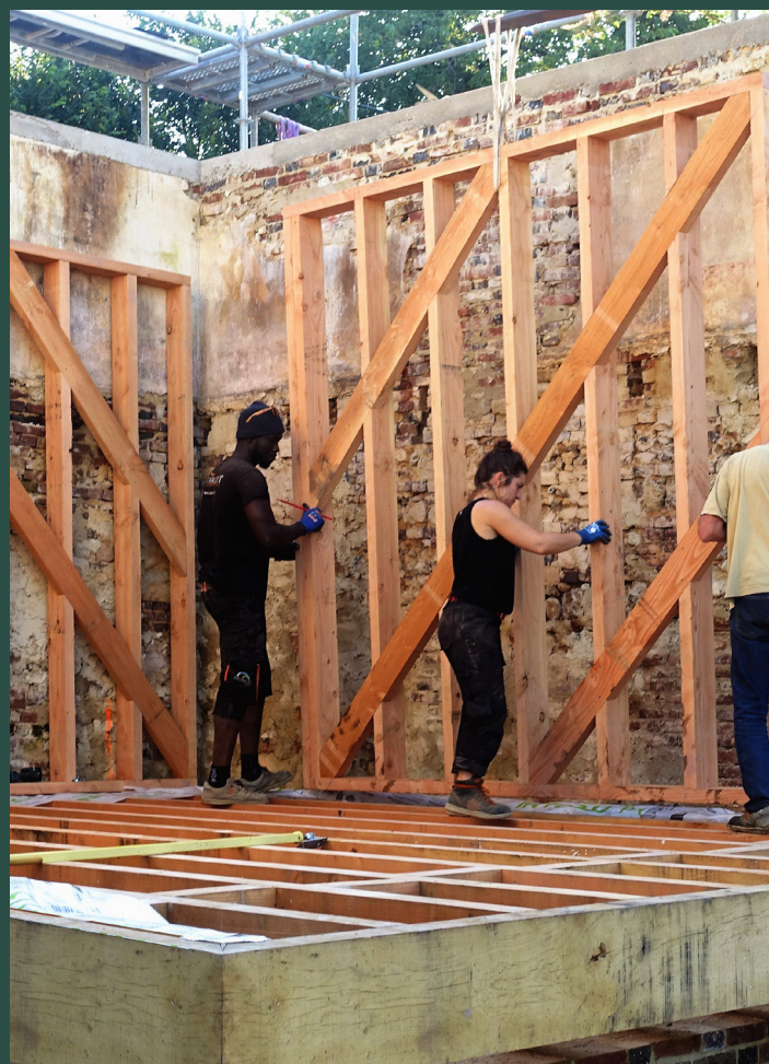
Pose des colombages de l'extension
