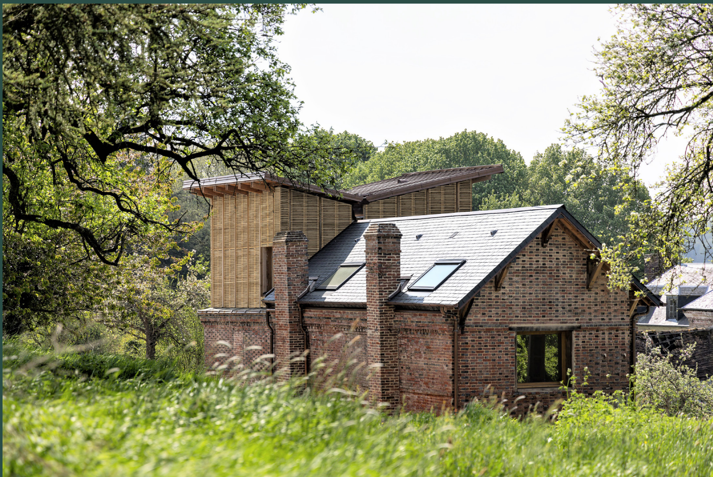
La rénovation vue côté ouest
