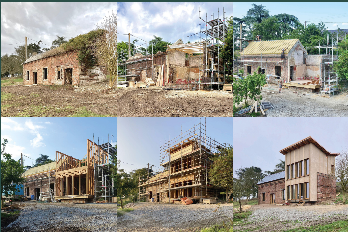
Les différentes étapes du chantier de rénovation
