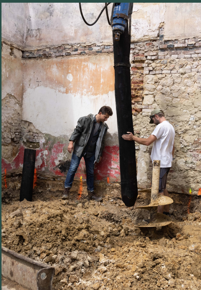
Fondations en pieux de robinier
